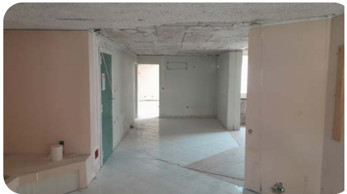
(Travaux en cours)
