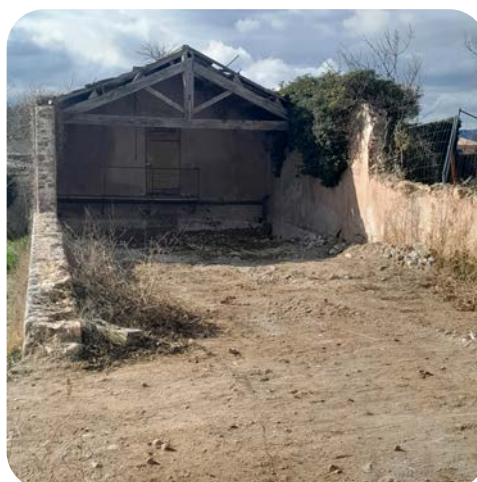
Démolition du bassin pour création d'un parvis
