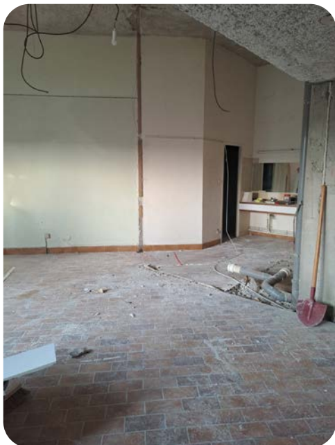
(Travaux en cours)
